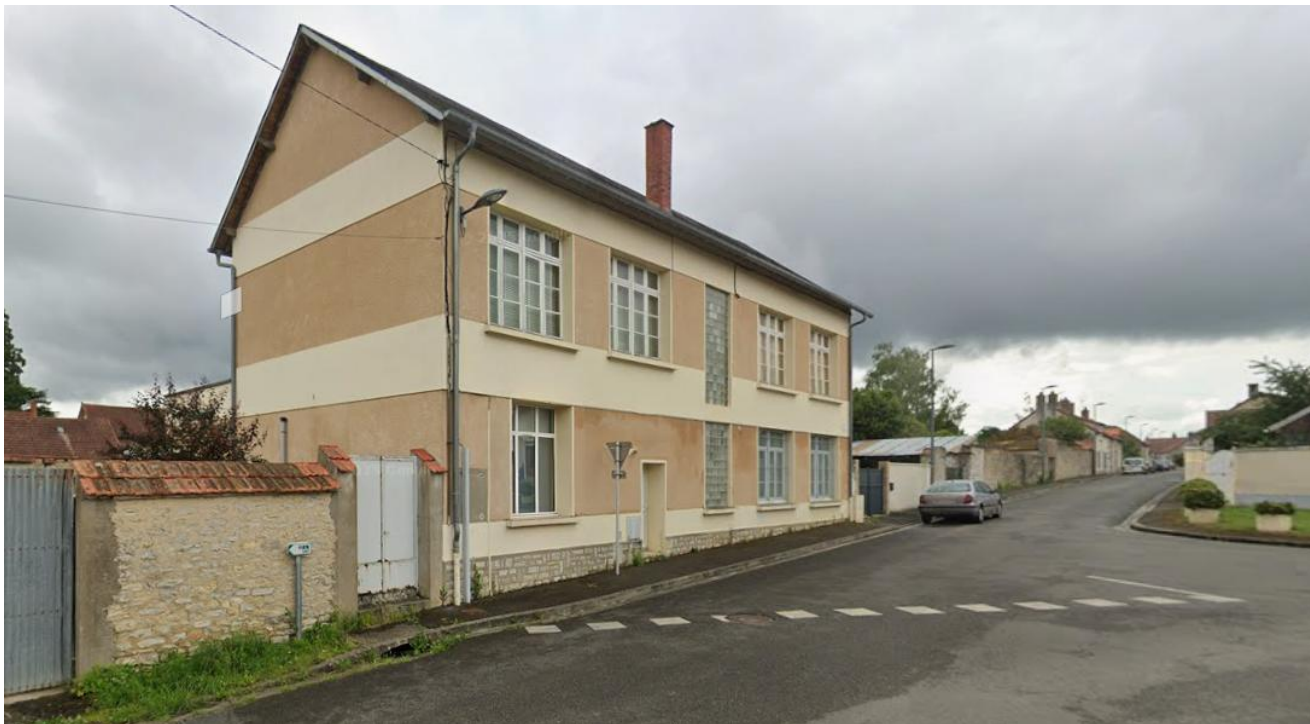
Façade côté rue Grévy
