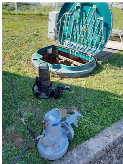
Renouvellement d'une pompe au poste de relèvement ZAC des Grivelles
